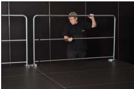
Bühnengeländer hinten aufstecken Sicherungsschrauben festziehen
