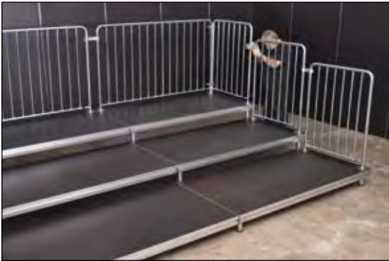
Tribüne aufstellen und Geländer anbringen
