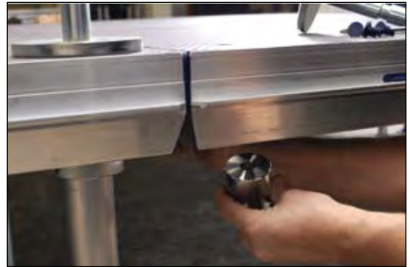
Detail: Adapter in Fußaufnahme einstecken und sichern
