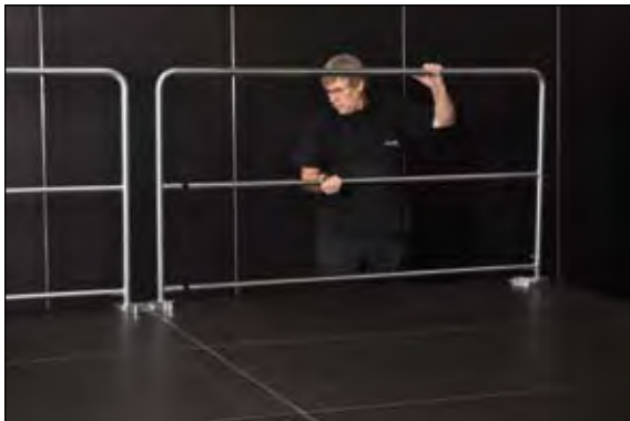
Bühnengeländer hinten aufstecken Sicherungsschrauben festziehen
