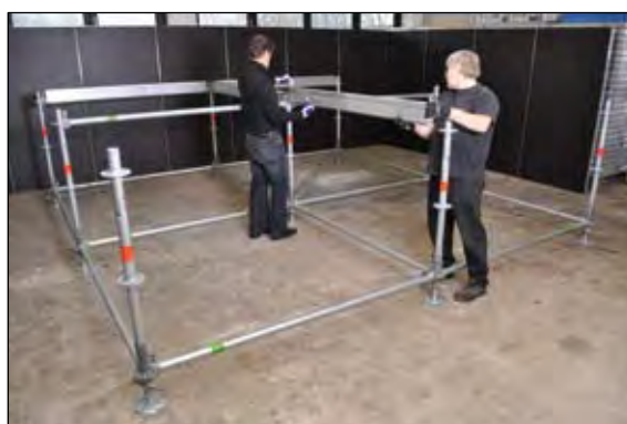
Lastenträger nach Plan einsetzen
