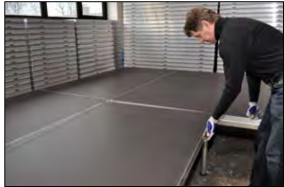
Feder in Nut einhängen
