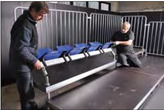
Sitzträger aufstecken und sichern
