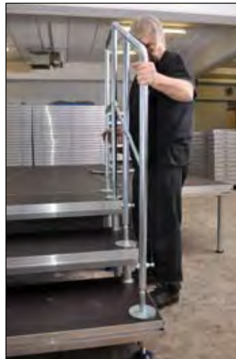
Geländer zusammenstecken auf Bolzen aufstecken und sichern
