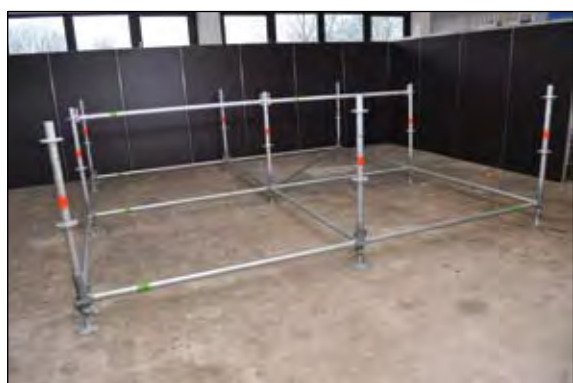
Gerüstkonstruktion nach Plan aufstellen
