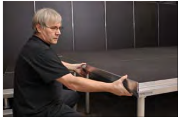
Verblendungsleisten direkt einhängen
