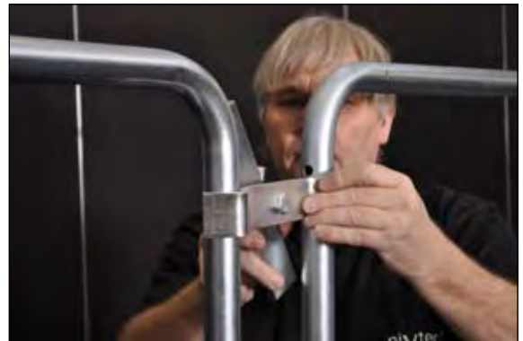
Geländer-Verbinder 150 mm einsetzen
