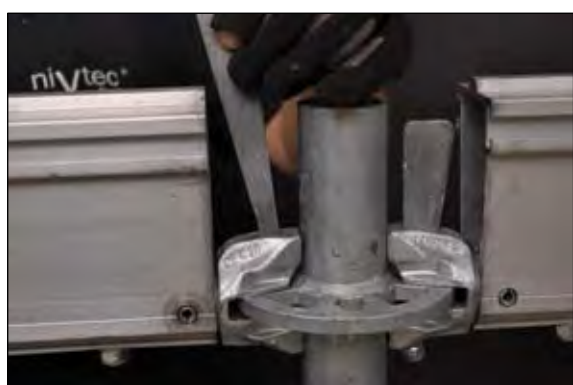
Keilkopf in Lochscheibe einstecken...
