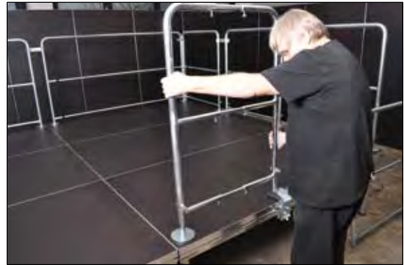
variables Geländer (Breite verstellbar)
