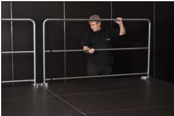
Bühnengeländer hinten aufstecken Sicherungsschrauben festziehen
